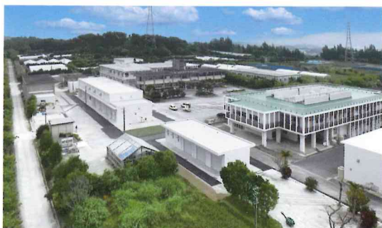
沖縄県農業研修センター (H30年)
