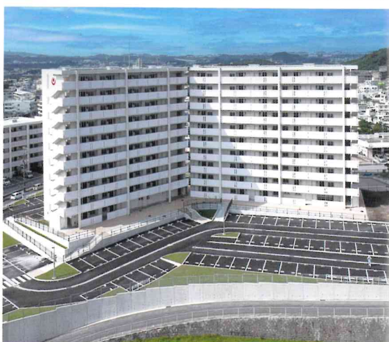
県営南風原団地建替工事 (R1年)
